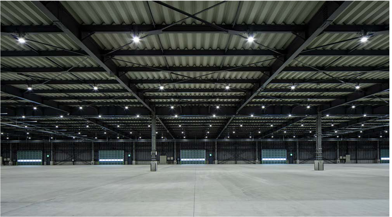
荷捌場内全景
