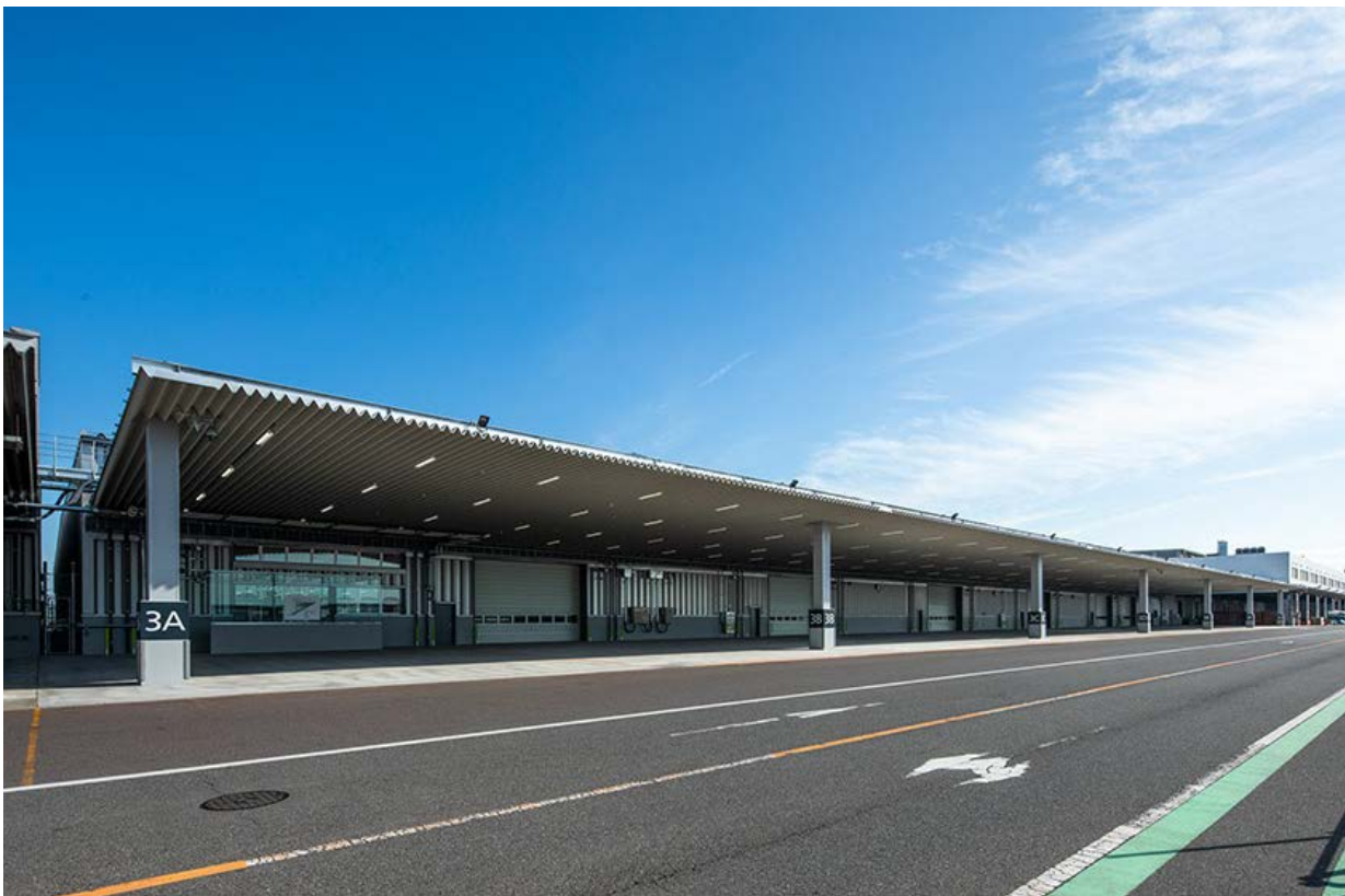
建物外観 （トラックヤード側）
